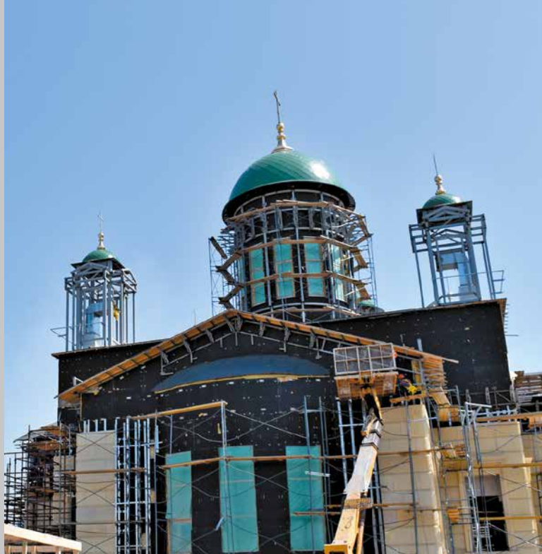
Строительство храма шахты «Сибирская»
