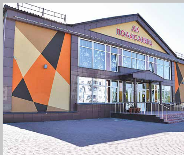
Отремонтированный фасад Дома культуры «Польсаевец»
